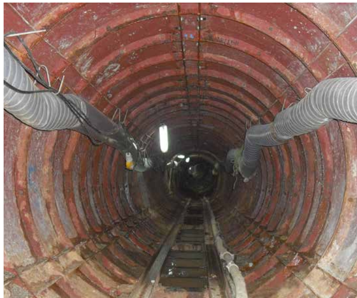
相片1 - 使用預製組件建造的隧道
