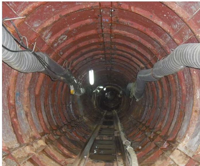
相片1 - 使用预制组件建造的隧道
