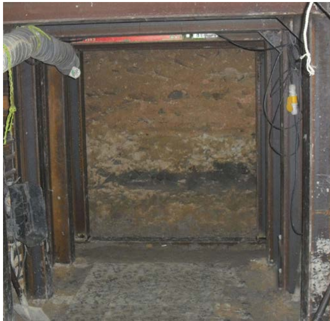
相片2 - 板仔龙隧道
